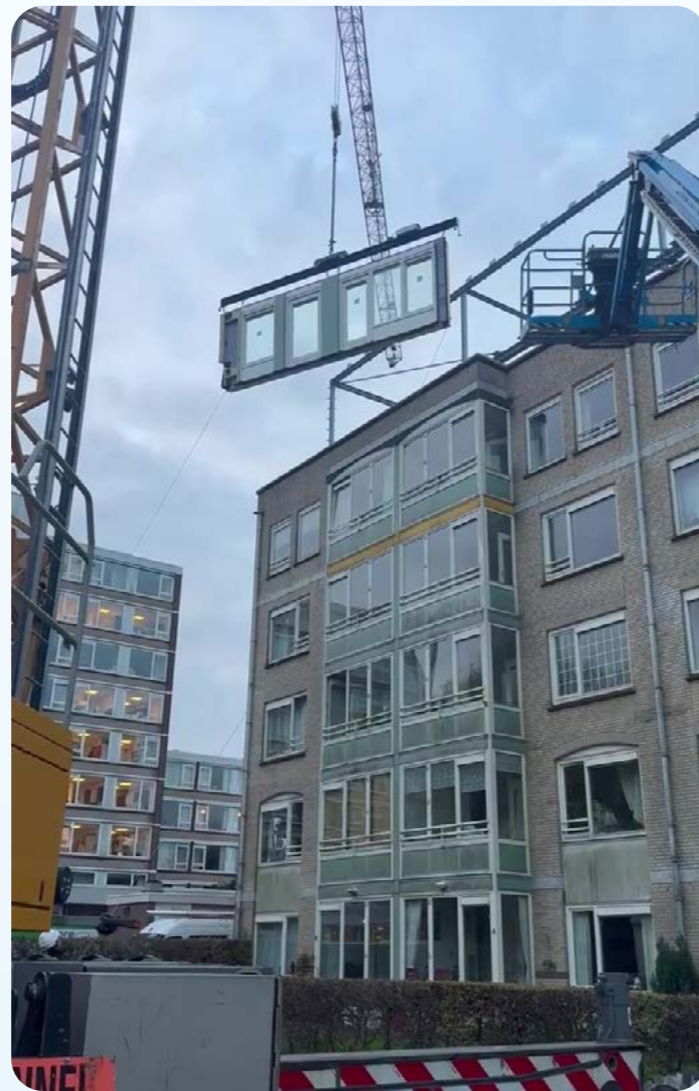
HIJSMOMENT OPTOPPROJECT MEYBURG
